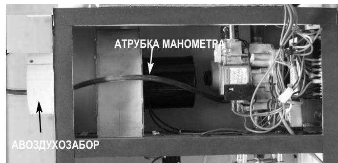
7. Снимите заглушку контрольного отверстия с выходного отверстия газорегулирующего клапана. Надёжно подсоедините манометр. См. рис.34.
